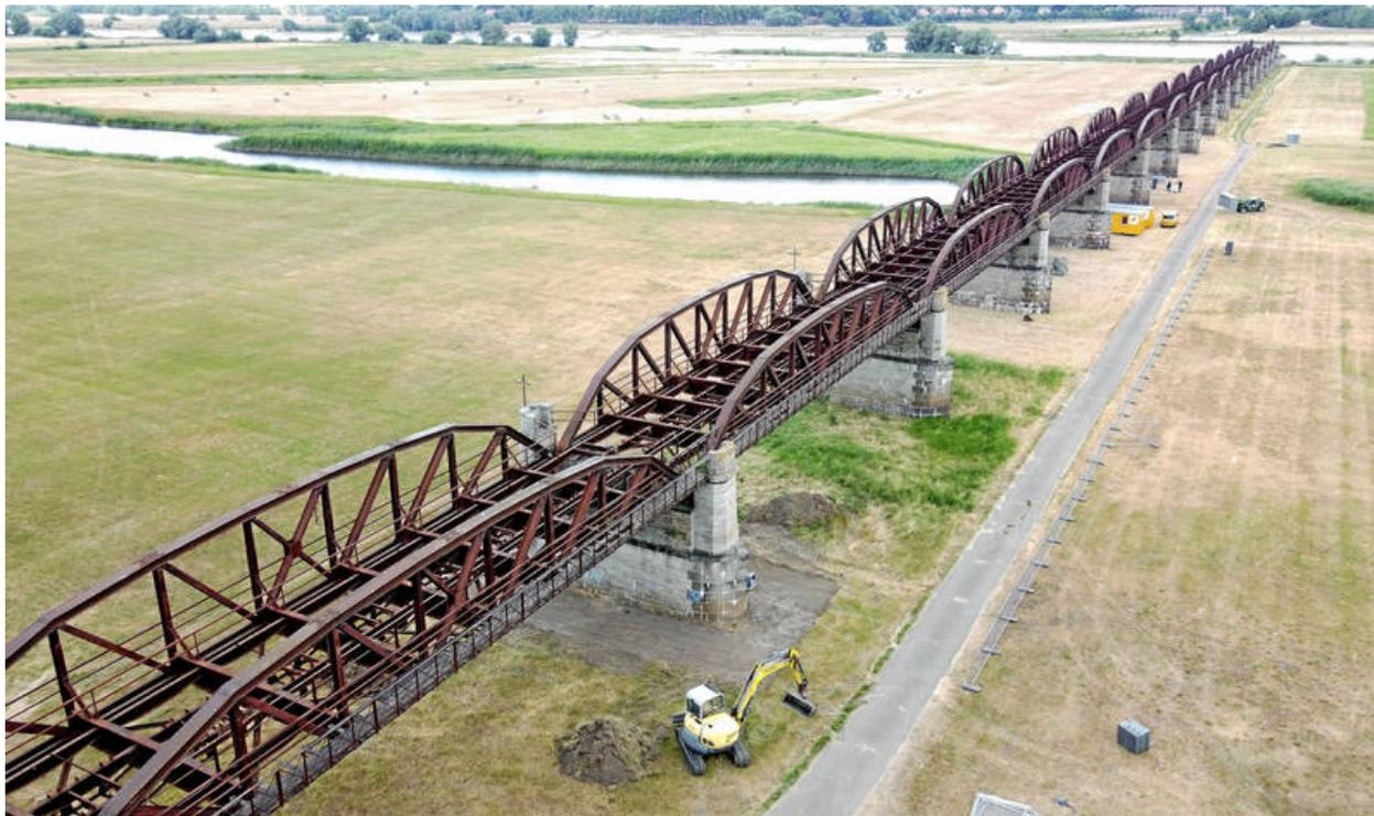
Der erhaltene Teil der ehemaligen Dömitzer Eisenbahnbrücke ist gut 500 Meter lang und setzt auf 16 Brückenpfeilern sowie dem bereits 2018 sanierten Kopfbauwerk. Bis Ende Juni 2023 müssen die nun begonnenen Sanierungsarbeiten des Stahlbaus und des Naturstein-Mauerwerks abgeschlossen sein, damit die Millionen-Förderung sicher fließt. Aufn.: J. Zahlmann
